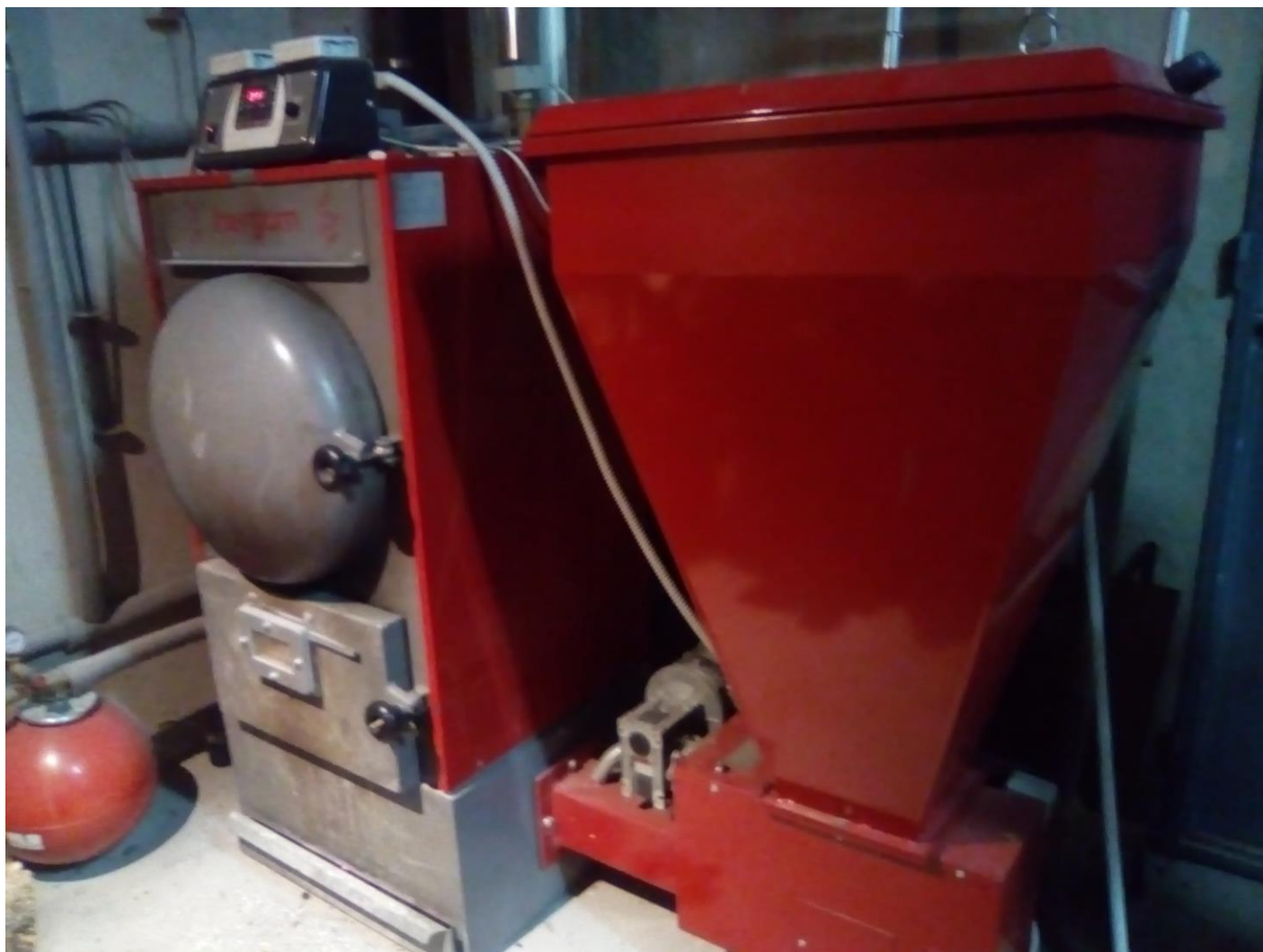
Kotol na výlisky, ktorý sa používa na vykurovanie domácností
